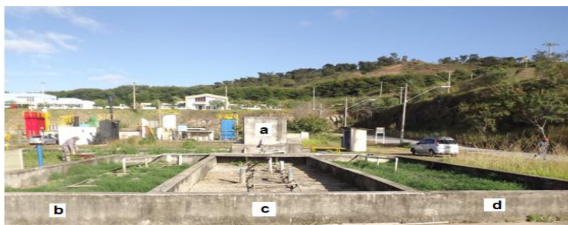
Figura 4: Vista geral do sistema de tratamento estudado após quatro anos de operação; (a) caixa de alimentação, (b) unidade plantada com Tifton 85– UP, (c) unidade não plantada (controle) – UC, (d) unidade previamente plantada com Taboa e depois recoberta com Tifton 85.
