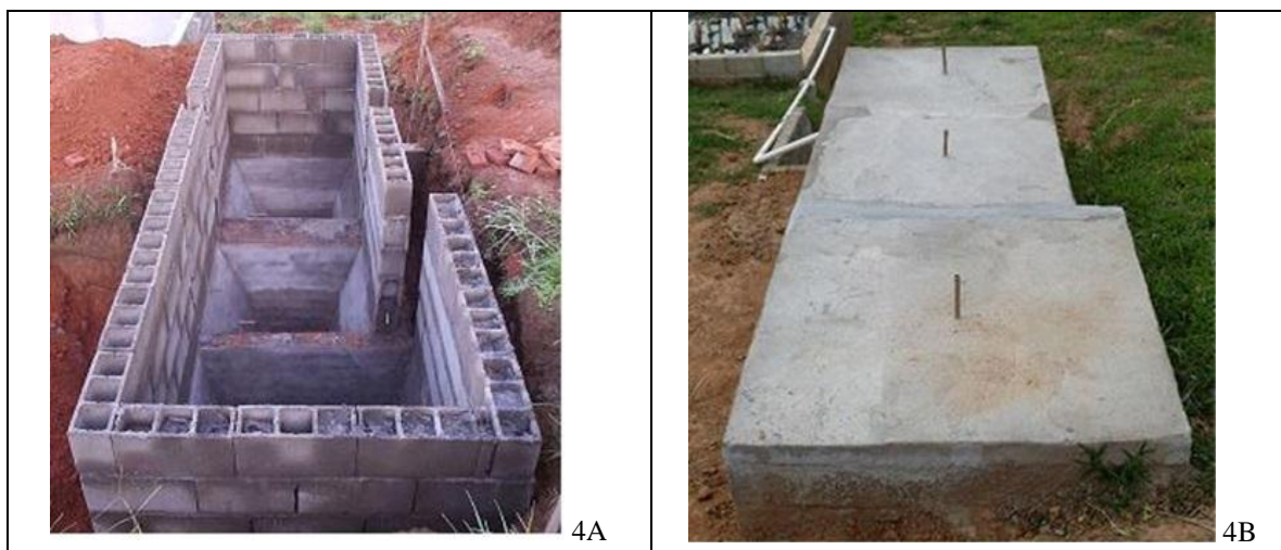
Figuras- 4A e 4B: Vista interna e externa do Reator Anaeróbico Compartimentado do sistema de tratamento de efluente de bovinocultura de leite.
