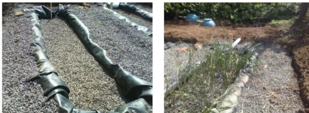
Figura 2 – Detalhe da manta, material suporte e macrófita utilizados nos wetlands construídos. Fonte: Autor, 2012.
