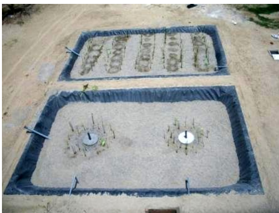
Figura 9: Start up da operação em novembro 2011
