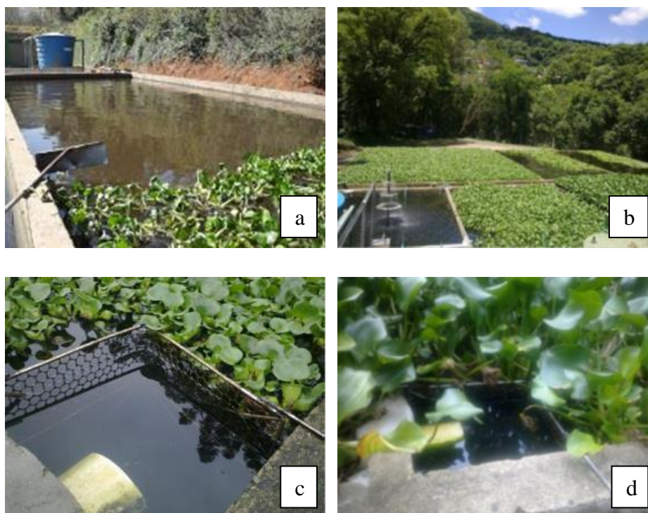
Figura 2: a: Implantação do Sistema; b: Sistema de Polimento após dois meses; c: Grelha após 2 meses; d: Grelha após 6 meses
