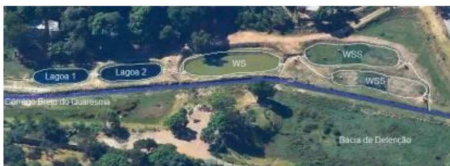
Figura 17: Imagem aérea do sistema de tratamento das águas do córrego Brejo do Quaresma: Lagoas 1 e 2 = lagoas de decantação; WS = Wetland de fluxo superficial; WSS = Wetland de fluxo subsuperficial.
