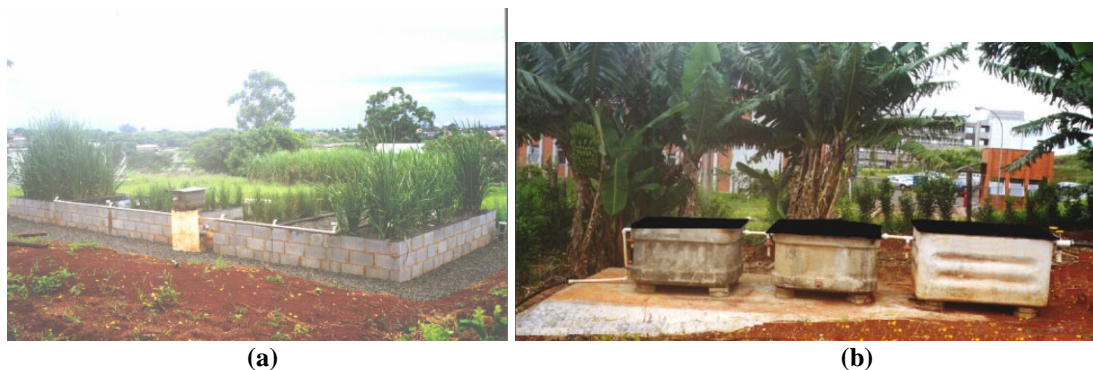
Figura 1: (a) Leitos cultivados (“constructed wetlands”) e (b) tanque séptico modificado
