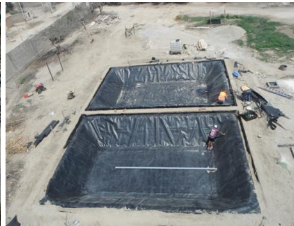
Figura 5: Impermeabilização com lona HDPE
