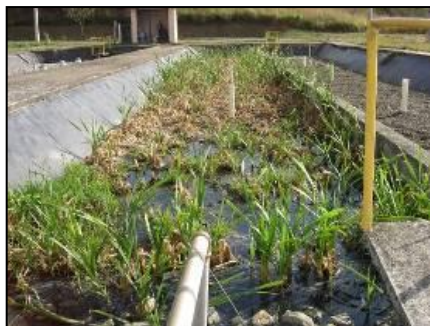
Figura 3: Imagens do escoamento superficial indesejado na wetland plantada, recentemente podada, e na wetland não plantada.
