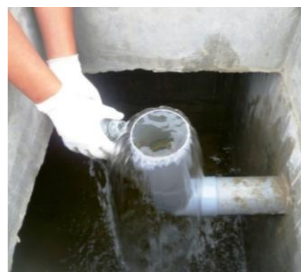
Figura 11: Efluente final (saída do dreno, entrada reservatório).
