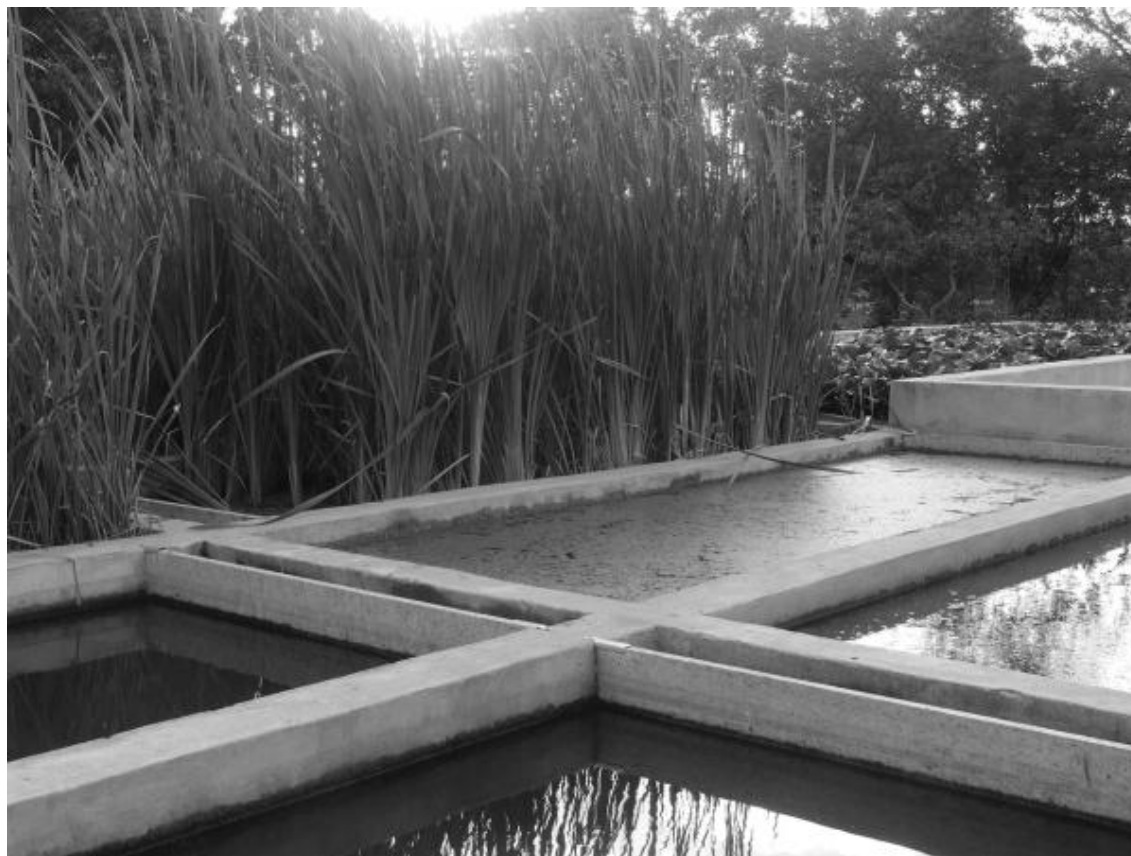
Figura 2 - Aspecto do sistema de alagados construídos definitivo.
