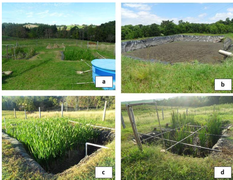
Figura 1 – Estação de tratamento no CAFW : (a) vista geral; (b) lagoa de decantação; (c) WCH; (d) WCV.
