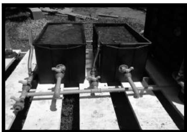
Figura 2: Wetlands preenchidas com substrato de cacos de telha
