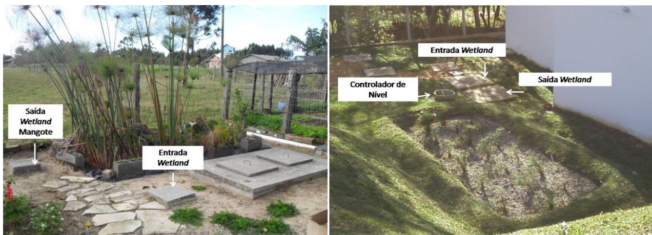
Figura 1 - Tanque séptico seguido de wetland horizontal tratando águas cinzas na propriedade rural em Palhoça/SC (à esquerda), e sistema de tratamento de águas cinzas na sede da empresa em Florianópolis (à direita).
