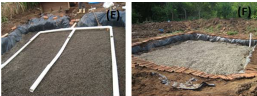
Figura 02: Preenchimento do filtro. (A): Instalação da tubulação no interior da ETE; (B): Camada de 10 cm de brita nº 1; (C) Preenchimento com 40 cm de areia grossa; (D): Preenchimento com 40 cm de brita nº 1; (E): Instalação da tubulação de distribuição do efluente; (F): cobertura com brita nº 0.
