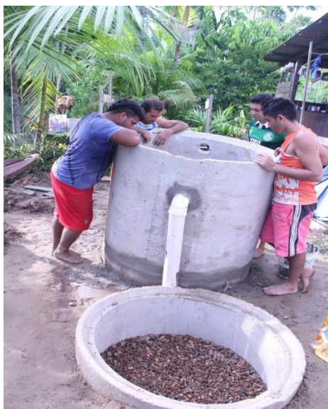
Figura 5 – Participação da comunidade na construção das fossas sépticas com filtro anaeróbio na Ilha das Cinzas, Gurupá - PA.
