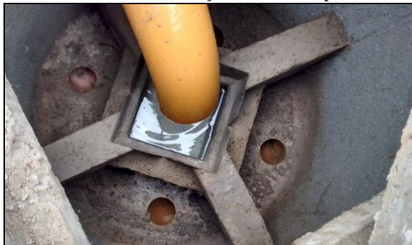
Figura 3 – Sistema de distribuição do afluente para as unidades
