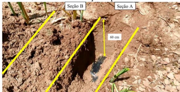
Figura 5 – Trincheira aberta na seção A para o revolvimento do leito
