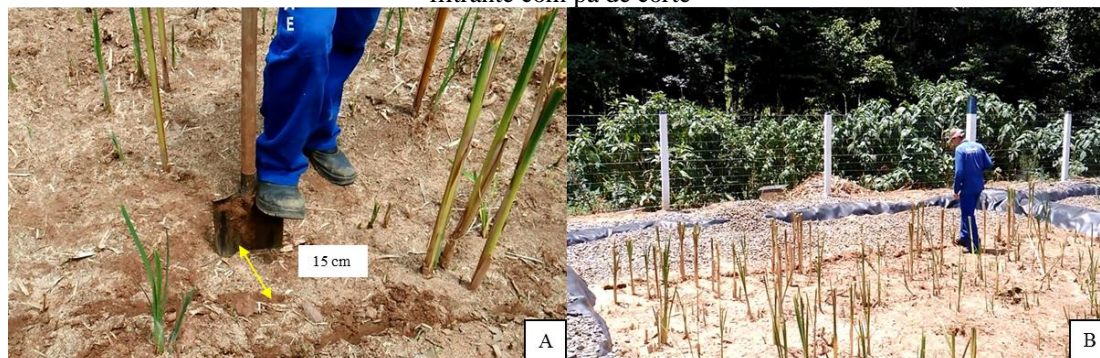
Figura 3 – As Figuras A e B mostram a execução do corte perpendicular ao fluxo no escoamento do leito filtrante com pá de corte
