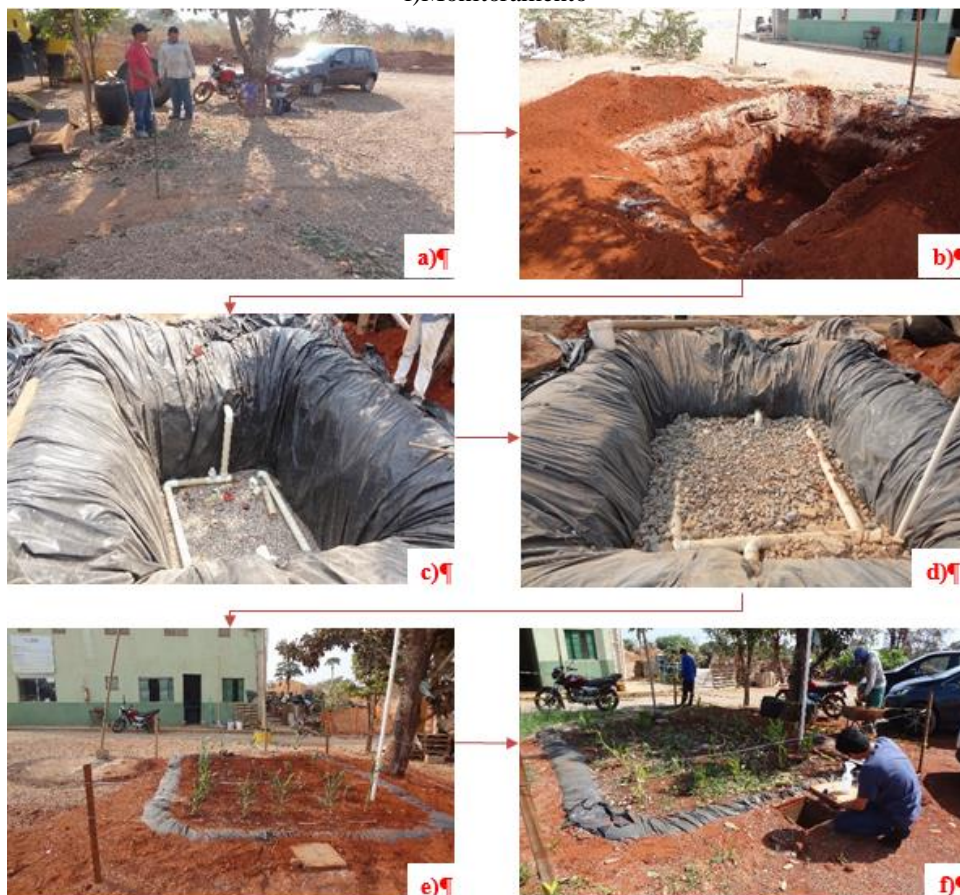
Figura 4 – Etapas de execução da wetland: a) Demarcação da área; b) Escavação; c) Preenchimento com brita zero reciclada e instalação da tubulação de saída; d) Preenchimento com rachão reciclado e instalação da tubulação de entrada; e) Preenchimento (terra + material orgânico) e plantio das mudas; f) Monitoramento
