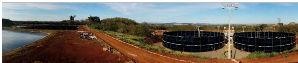
Figura 2: Foto da fase da realização da nova ETE de Santa Helena (outubro 2019)
