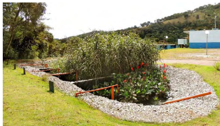
Figura 1 Unidade de Gerenciamento de Lodos por Wetlands Construídos em Itabirito MG.
