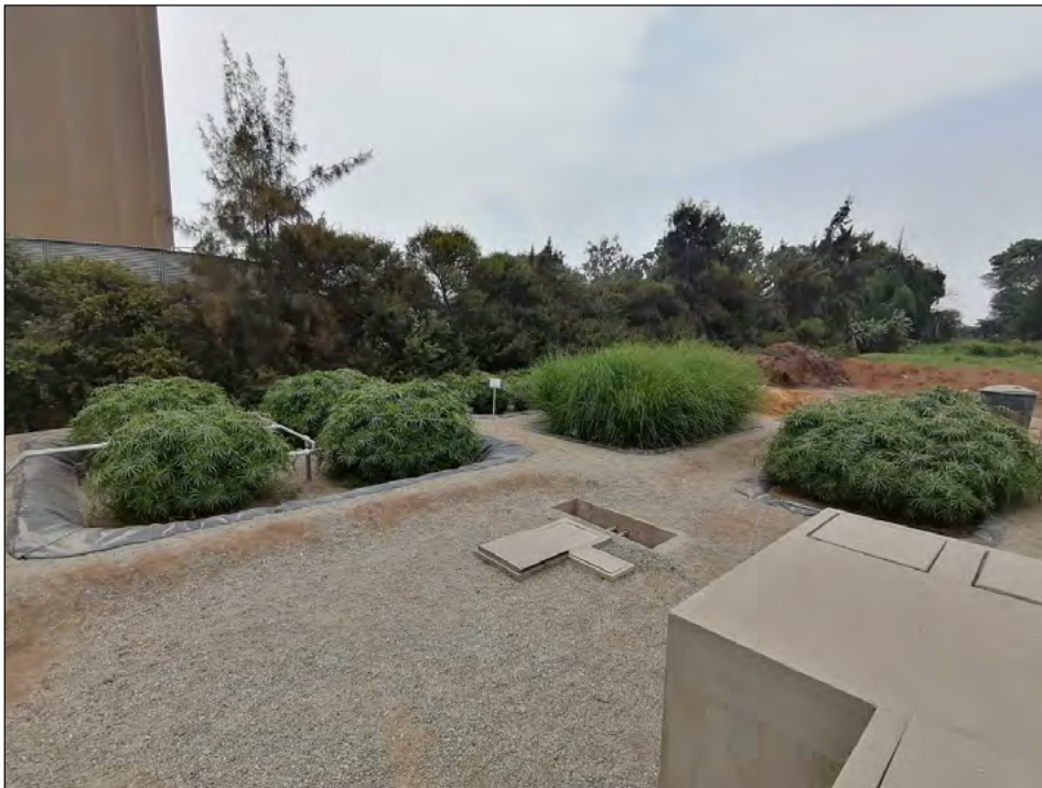
Figura 1. Planta Piloto de tratamiento de aguas residuales – UNALM.
