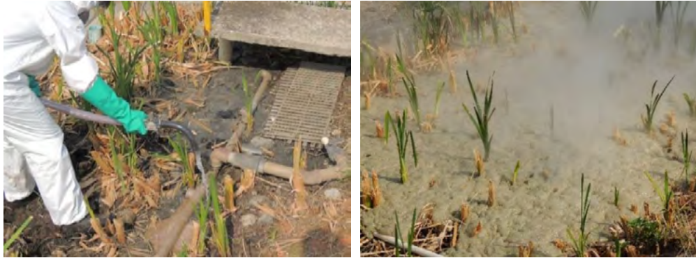
Figura 1 Momento de aplicação do peróxido de hidrogênio em um wetland de escoamento horizontal. Início da aplicação (esquerda) e reação acontecendo (direita).
