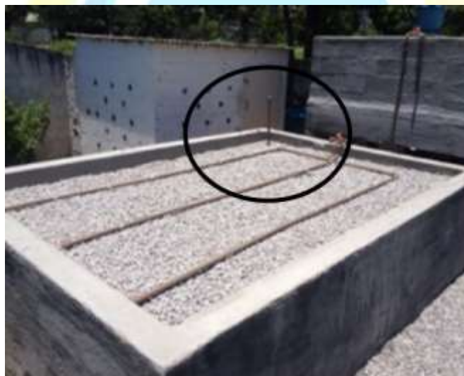
Figura 3 - Implantação de amostradores em ponto intermediário no Wetland construído vertical de fundo saturado
