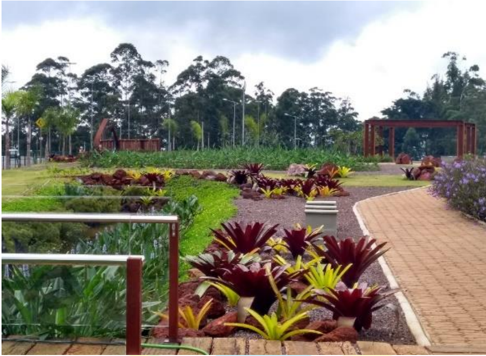
Figura 4: Wetlands para tratamento de esgoto sanitário na Mina de Águas Clara - Vale.
